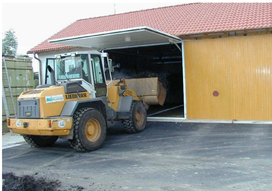
Rys 6 Przykład komór fermentacji typu garażowego [1]
