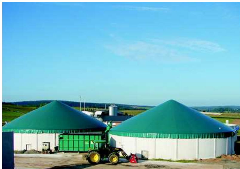
Rys 1 Przykład zintegrowanych komór fermentacji i zbiorników biogazu na biogazowni rolniczej Sachsenhagen (archiwum LimnoTec GmbH).
