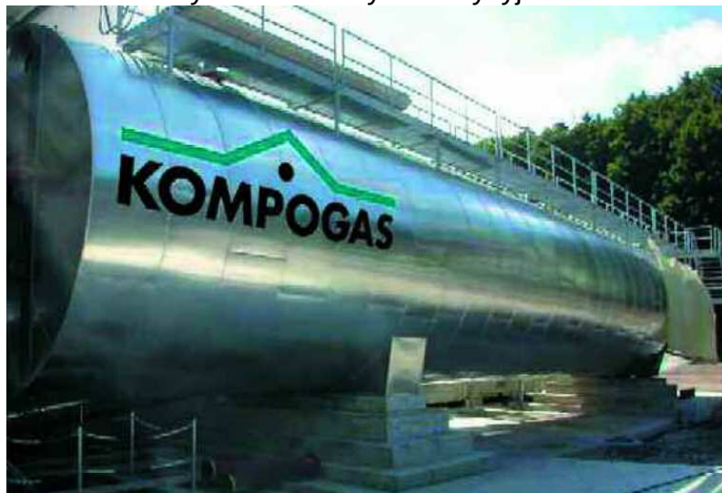
Rys 4 Przykład komory fermentacji typu leżącego (źródło: firma KompoGas)
